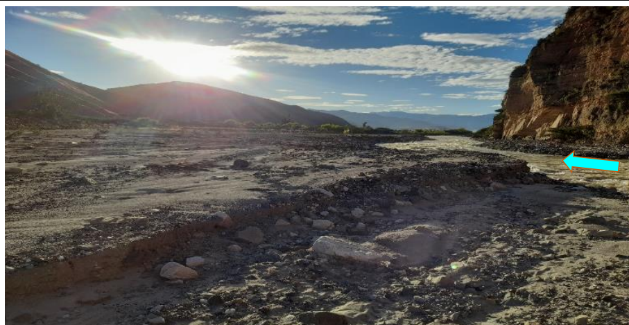
FIGURA N°01: TRAMO CRÍTICO EN EL RIO CONDEBAMBA EN EL SECTOR VILCAS SE APRECIA AGUAS ABAJO LA NECESIDAD DE ENROCADO EN LA MARGEN IZQUIERDA
